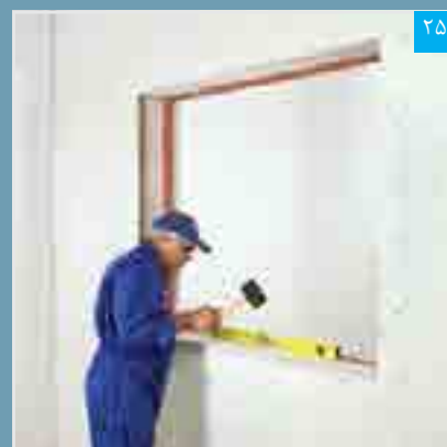
۲۵ تنظیم پنل نواری (تراز کردن)
