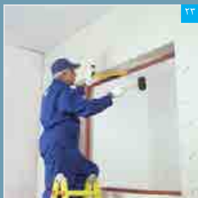
۲۳ تنظیم پنل نواری (گوتیا کردن)
