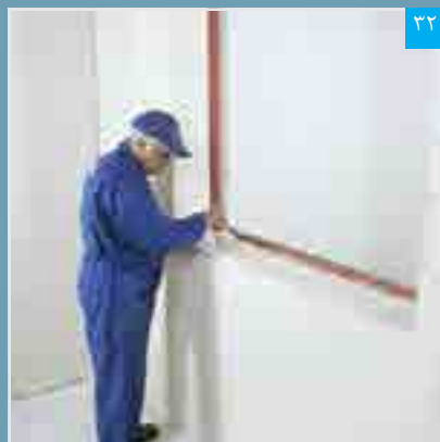
اجرای پرایمر بر روی سطح پنل
