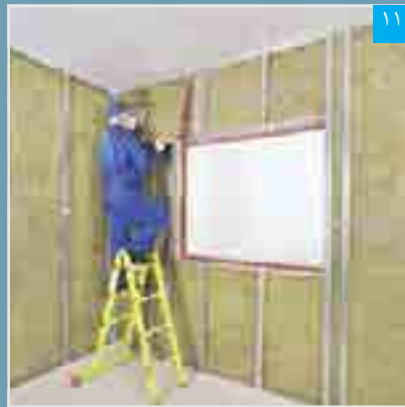
۱۱ اجرای عایق پشم معدنی
