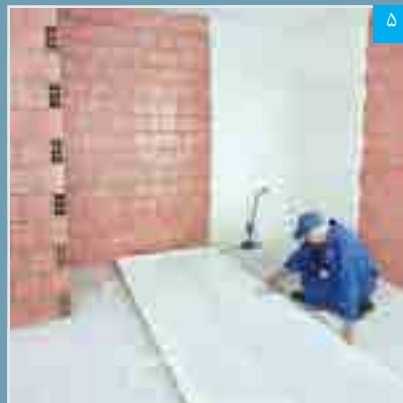
اجرای لایه بتونه درزگیر (به صورت شانه‌ای) بر پشت پنل مرکب PS
