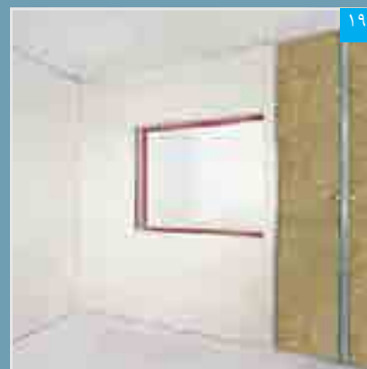
۱۹ پوشش کاری تکمیل شده در ناحیه بیرونی بازشوی پنجره
