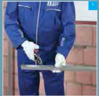
۱ برش انتهای سازه‌های افقی قاب بندی بازشوی پنجره (به اندازه ۲۰ سانتیمتر و به صورت فارسی بر)
