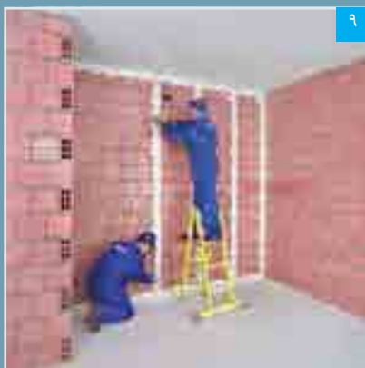
تنظیم نهایی کرم نصب شده با شمشه و چکش لاستیکی
