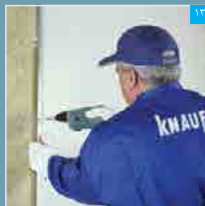
توجه: پنل‌ها باید در جهتی نصب شوند که لبه آزاد آن‌ها به سمت دهانه باز استاداها قرار گیرد
