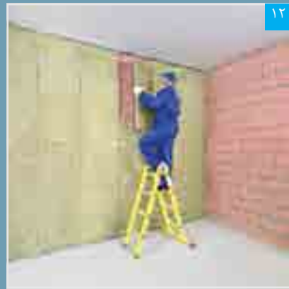
۱۲ اجرای عایق پشم معدنی
