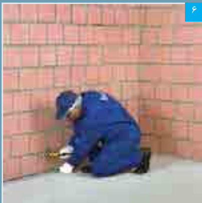
۶ نصب سازه هادی کف
