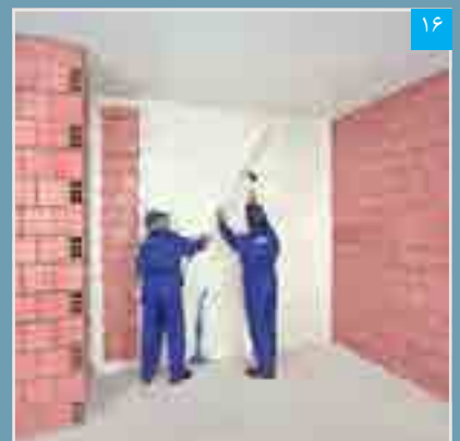
۱۴ نصب و تنظیم پنل، با پنل نصب شده مجاور
