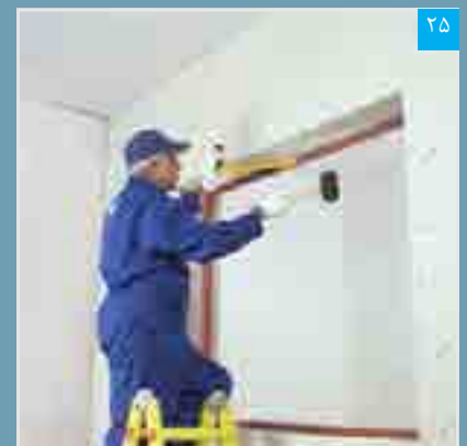
تنظیم پنل نواری (گونیا کردن)
