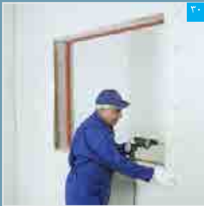
اتصال پنل نواری به سازه قائم
