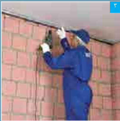
۳ نصب سازه هادی سقف
