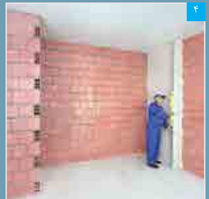
بررسی تراز و تنظیم بودن پنل نصب شده با استفاده از شمشه و تراز
