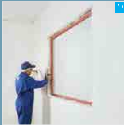
اجرای پرفیکس بین پنل و دیوار بنایی (دور تا دور بازشوی پنجره)
