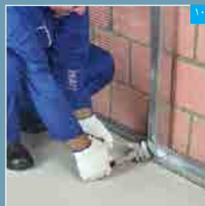
اتصال و تثبیت استاداها به رانرها (به وسیله پانچ، پرچ یا پیچ)
