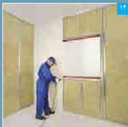
نصب پنل بر روی زیرسازی
