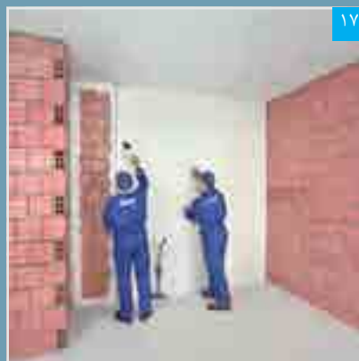
۱۸ تنظیم نهایی پنل نصب شده با شمشه و چکش لاستیکی
