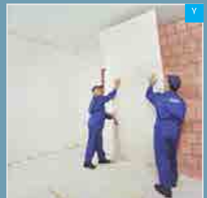
استقرار پنل بر روی دیوار زمینه
