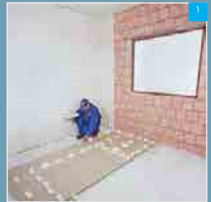
اجرای چانه های پرفلیکس بر پشت پنل
