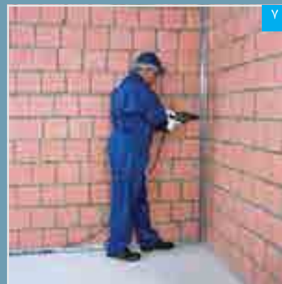
نصب اولین استاد بر روی ساختار جانبی
