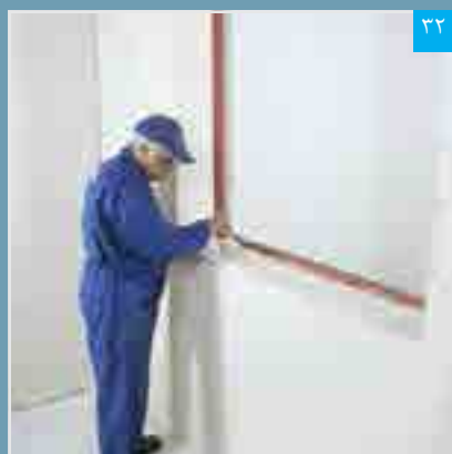
اجرای پرایمر بر روی سطح پنل
