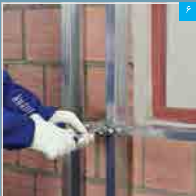
۶ اتصال رانر قاب بندی تحتانی به استاد به وسیله پانچ، پرچ یا پیچ (به جهت برش ۴۵ درجه توجه شود)
