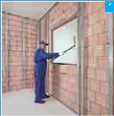
۳ استقرار سازه قاب بندی تحتانی (به جهت خم‌ها توجه شود)
