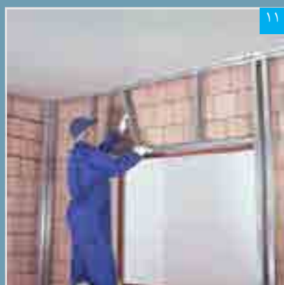
استقرار استادها در راتر سقف و راتر قاب بندی فوقانی
