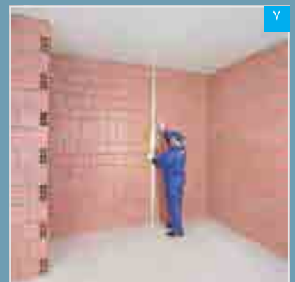
مشخص کردن محل اجرای چانه های پرل‌فیکس بر روی دیوار زمینه
