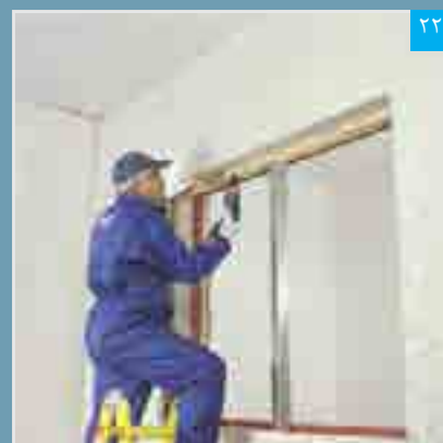
۲۲ اتصال پنل نواری به سازه قاب بندی فوقانی
