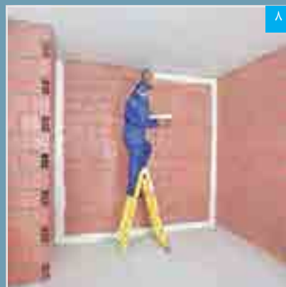
اجرای پرل‌فیکس به صورت نوار پیوسته در حاشیه پیرامونی دیوار زمینه
