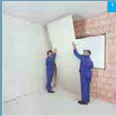
استقرار پنل بر روی دیوار زمینه
