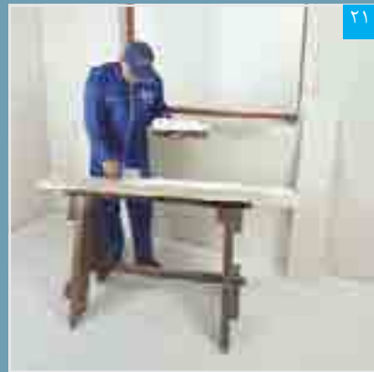
اجرای پرفیکس بر پشت پنل نواری (به اجرای یکپارچه پرفیکس توجه شود)
