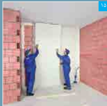
۱۶ پنل ها بر روی محور مرکزی کرم ها مستقر می شوند
