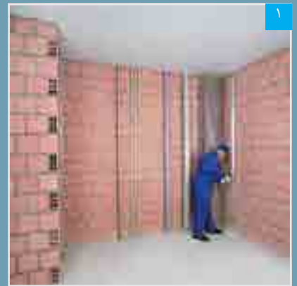
نصب اولین رانر بر روی ساختار جانبی
