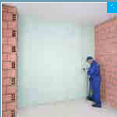
نصب لایه دوم پنل‌ها و تکمیل ساختار
