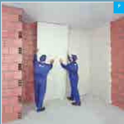
استقرار پنل بر روی دیوار زمینه
