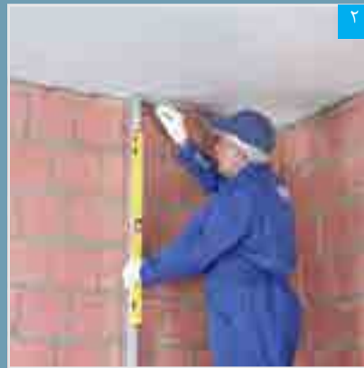
شمشه گذاری بر روی دیوار زمینه، جهت تعیین ناترازی آن و علامت گذاری روی سقف
