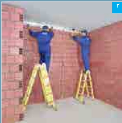
نصب و تنظیم کرم بالا با شمشه و چکش لاستیکی
