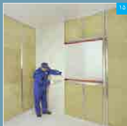
برش پنل با استفاده از اره
