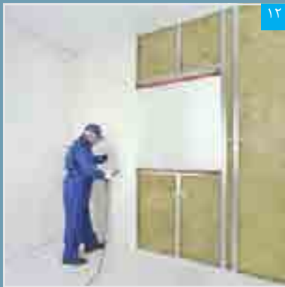
۱۲ نصب پنل بر روی زیرسازی
