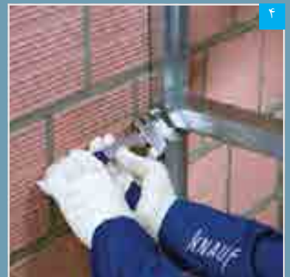
اتصل و تثبیت استاد به رانر (به وسیله پانچ، پرچ یا پیچ)
