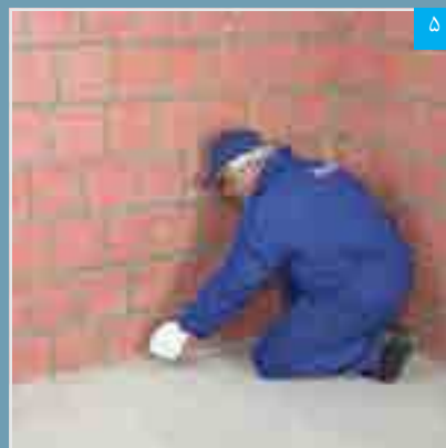
علامت گذاری مسیر لایه پوششی بر روی کف (با استفاده از ریسمان رنگی)
