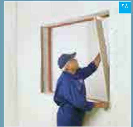
استقرار پنل نواری در ناحیه داخلی دور بازشوی پنجره (به اجرای یکپارچه پرفلیکس توجه شود)
