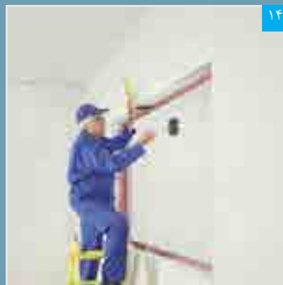
نصب و تنظیم پنل نواری
