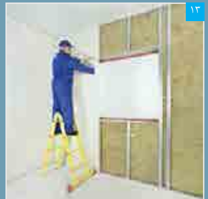
۱۳ برش پنل با استفاده از اره
