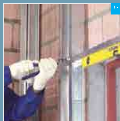
اتصال راتر قاب بندی فوقانی به استاد به وسیله پانچ، پرچ یا پیچ (به جهت برش ۴۵ درجه توجه شود)
