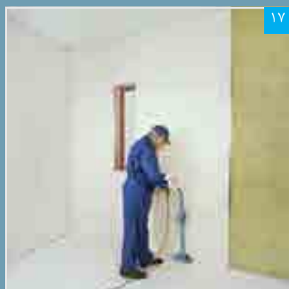
نصب پنل بر روی زیرسازی
