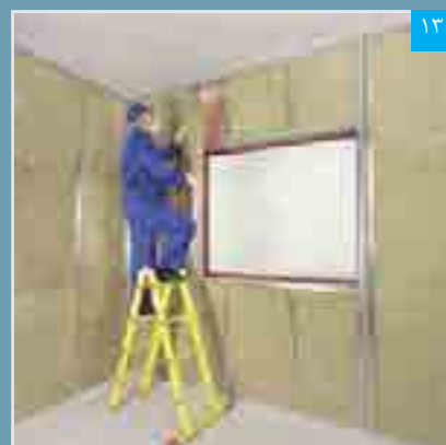
اجرای عایق پشم معدنی
