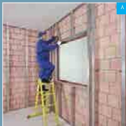
۸ استقرار سازه‌های قائم در سازه هادی سقف، سازه قاب بندی فوقانی و براکت‌ها
