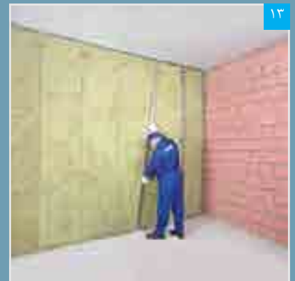
۱۳ استقرار سازه‌های قائم در سازه‌های هادی و میان براکت‌ها
