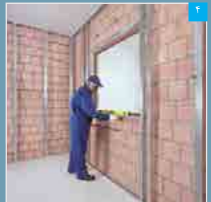
۴ تنظیم سازه قاب بندی به وسیله تراز
