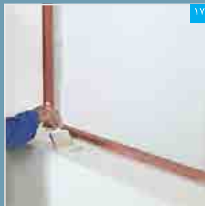
اجرای پرایمر بر روی سطح پنل
