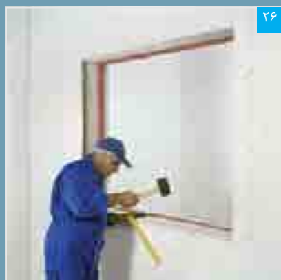
۲۶ تنظیم پنل نواری (گوتیا کردن)
