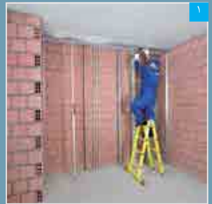
اجرای قاب پیرامونی (به روش مشابه ساختار W625)
