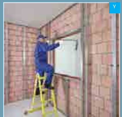
۷ استقرار سازه قاب بندی فوقانی (به جهت خم‌ها توجه شود)
