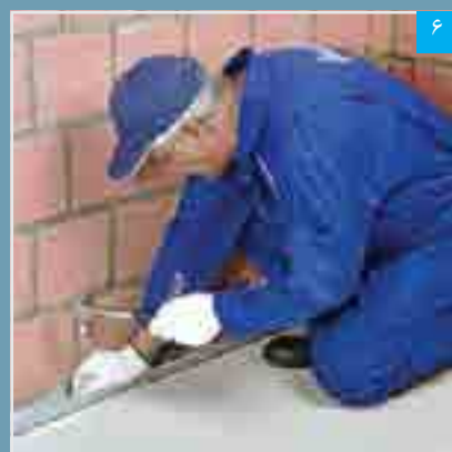
۶ نصب رانر کف
