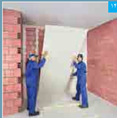
۱۳ پنل به سادگی توسط دو نفر قابل بلند کردن است
