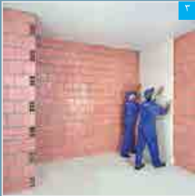
استقرار پنل بر روی دیوار زمینه
