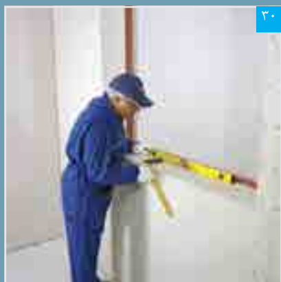
تنظیم پنل نواری (گونیا و تراز کردن)
