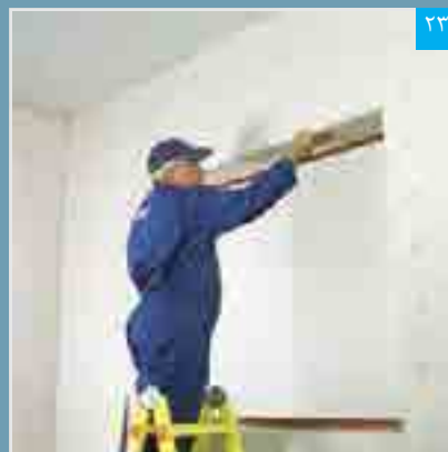
تنظیم لبه های پنل در محل کنج
