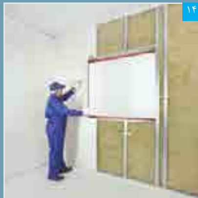
۱۴ برش پنل با استفاده از تیغ برش
