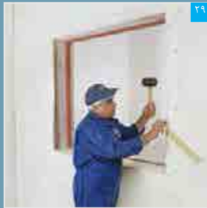
تنظیم پنل نواری (گونیا کردن)
