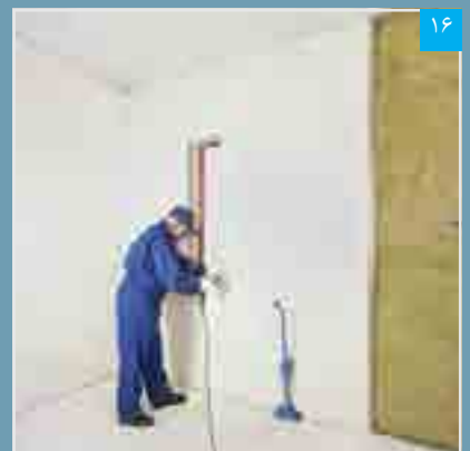
۱۶ نصب پنل بر روی زیرسازی
