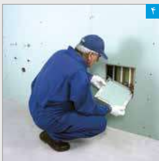
نصب قاب درب دریچه قرار دادن قاب اصلی دریچه درون دیوار و پیچ کردن آن به پنل
