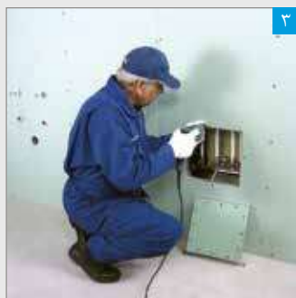
نصب قاب درب دریچه قرار دادن قاب اصلی دریچه درون دیوار و پیچ کردن آن به پنل
