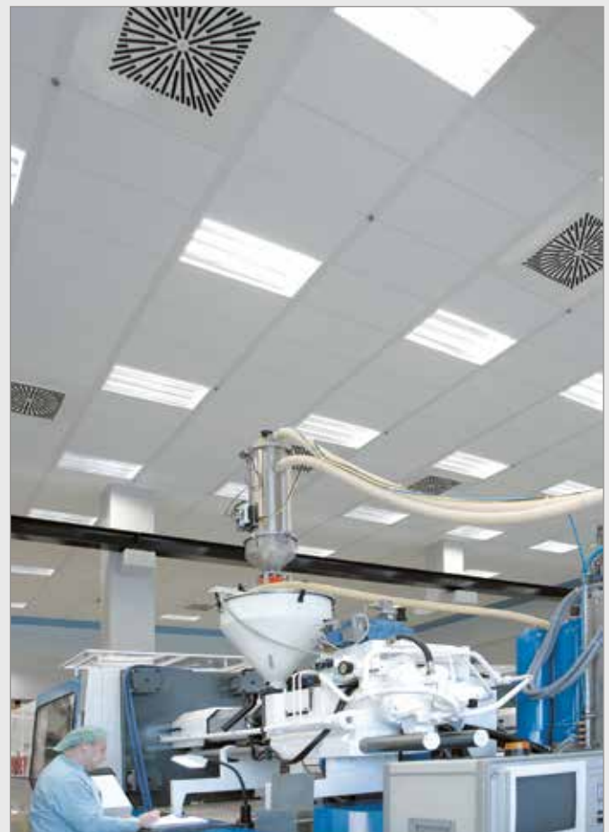
سقف کاذب ویژه اتاق تمیز (Clean room)
