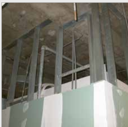
عدم امتداد یافتن پنل‌ها تا سقف اصلی
