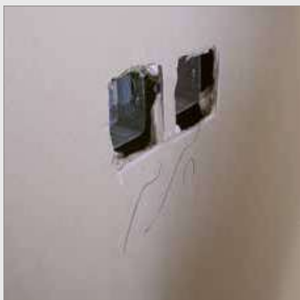
برش نامناسب پنل
