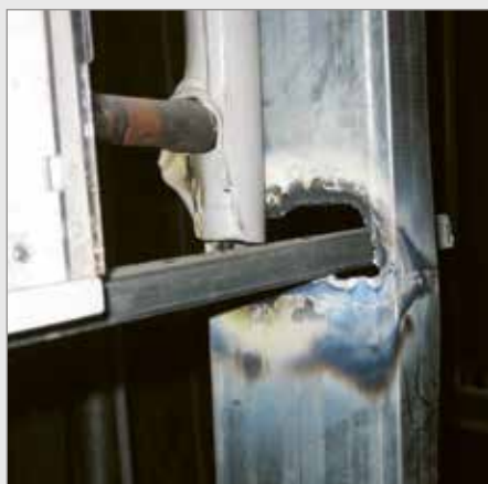
برش سازه با ابزار نامناسب
